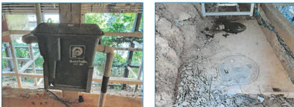
ภาพถ่ายที่ 3.4.5-1 ระบบบำบัดน้ำเสียสำเร็จรูปของโรงแรมสำหรับห้องพัก
